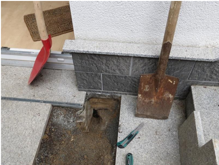
Bauteilöffnung Bauwerksabdichtung
